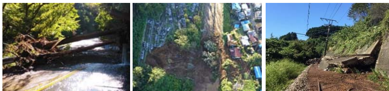
【国道20号】被害状況(倒木) 【中央道】被災状況(土砂崩落) 【JR中央本線】被災状況(土留壁崩壊)
